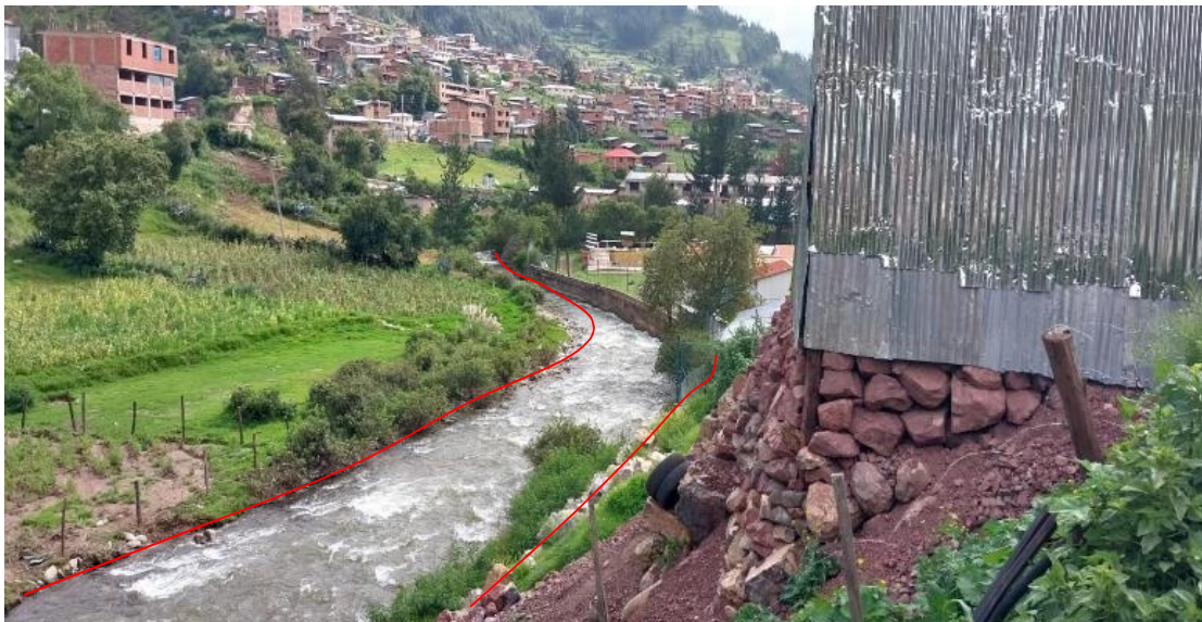
FIGURA N°03: PARTE BAJA DEL RIO PALLCCARO MARGEN IZQUIERDO Y DERECHO NO CUENTA CON PROTECCIÓN, DISTRITO DE TAMBOMBAMBA. COTABAMBAS, APURIMAC..
